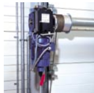
GfA elmotor med påbyggd växellåda
